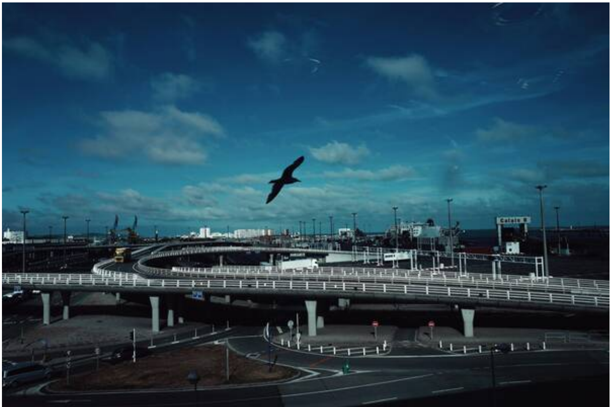
A Calais, lors d'un déplacement de Gérard Collomn en juin. (Photo Denis Allard/Rea pour Libération)
